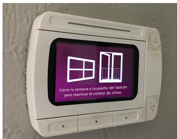
Gráfico 9. Control de apagado automático para aire acondicionado en función de la ventilación natural
