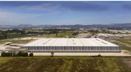
Terranum Bodega Mercurio
