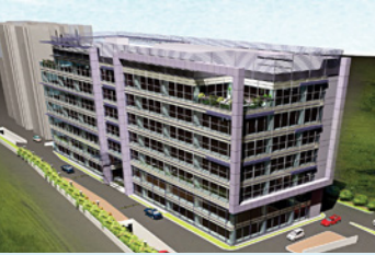
The Pavilion – Aurbis-ORR
