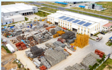
Nhà máy gia công cơ khí Ricons-Giai đoạn I
